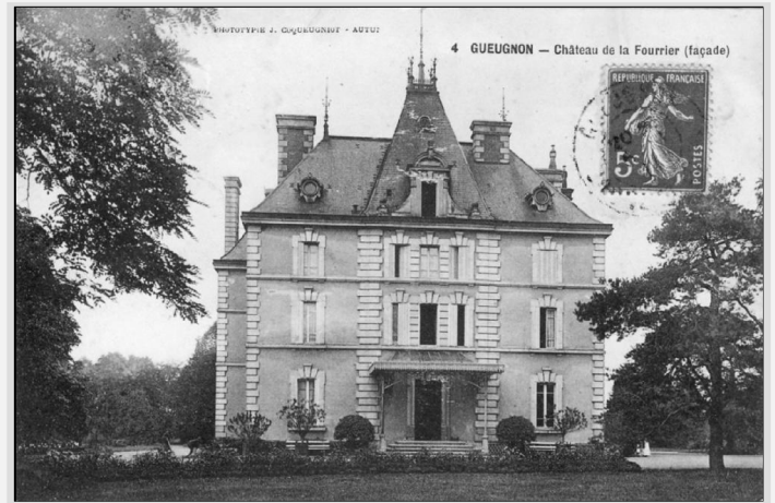
FAÇADE DU BÂTIMENT HISTORIQUE (MILIEU XXÈME SIÈCLE)
