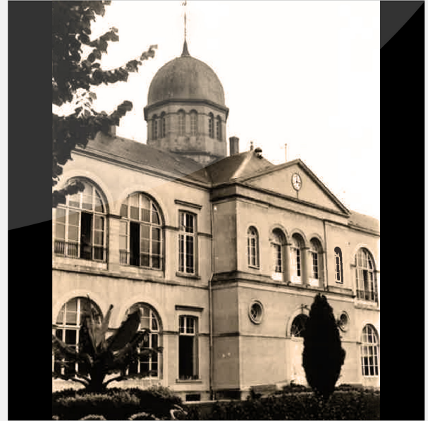
HÔPITAL DE CHAROLLES - BÂTIMENT HISTORIQUE (DÉBUT DU XX ÈME SIÈCLE)
